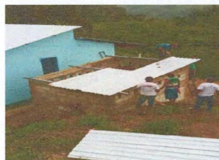
Foto 6: Rehabilitacion de cocina
