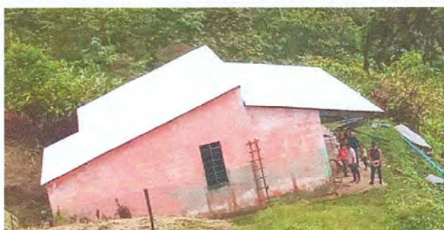
Foto 5: Aplicación de pintura, interior y exterior
