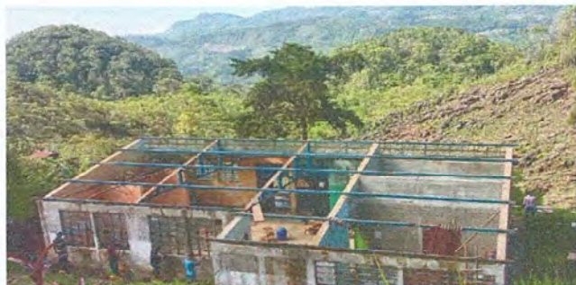
Foto1: Cambio de Costanera, aplicación de pintura en estructura
