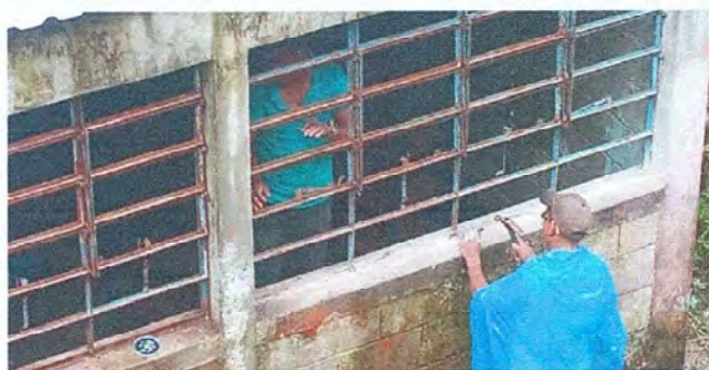
Foto 3: Mantenimiento de ventanas, cambio de vidrios
