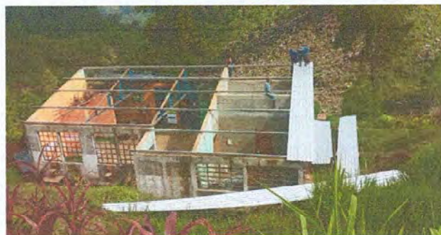
Foto 2: Instalacion de laminas troquelada
